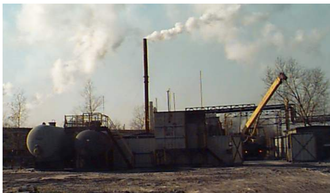
Рисунок 2 – Стационарный промышленный комплекс по обезвреживанию диоксино-содержащих трансформаторных масел. Утилизировано 132 тонны «сотвола-10» (I класс опасности). ОАО «Северсталь» г. Череповец, Вологодская обл. 1999-2004 г.
