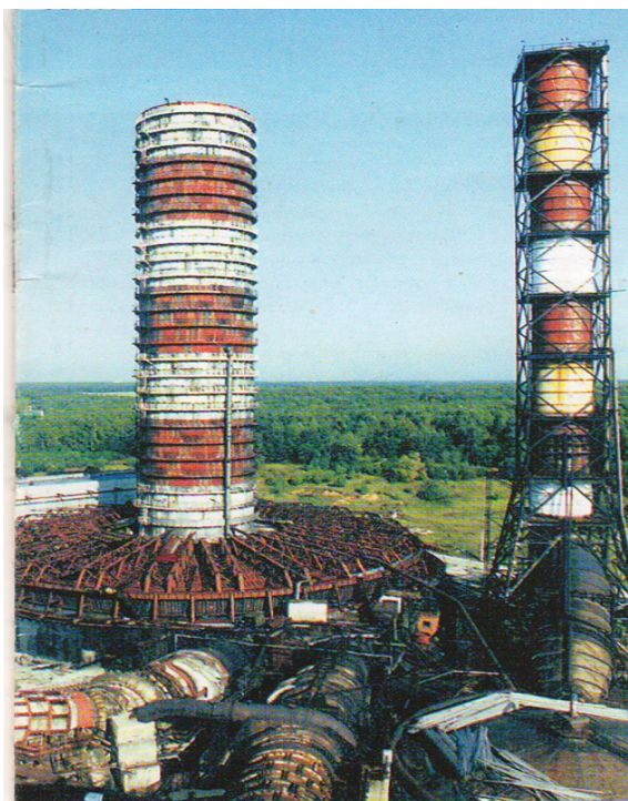
Рисунок 1. Самая крупная в мире камера сгорания (диаметр 5,5 м, длина 35 м) (внизу слева). Общий комплекс является базовым объектом выполненной космической программы «Энергия-Буран» (работает по настоящее время), г. Химки, Московская область.
