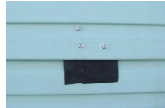
Установка датчиков температуры и тепловых потоков
