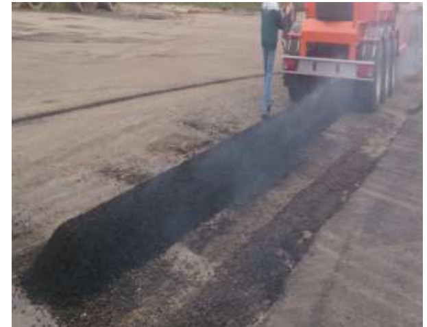
Формирование валика а/б смеси
