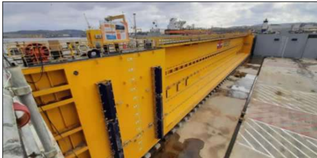
Батопорт сухого дока судостроительного комплекса «Звезда»
